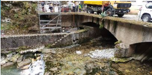
Mejora paso central Urdón
